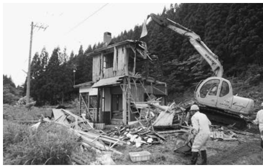
▲補助金を活用し、解体される空家
