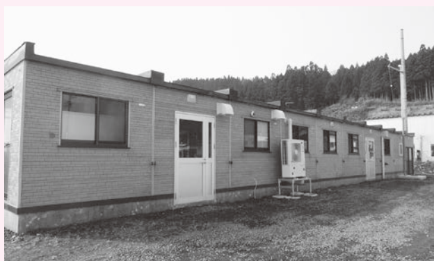
▲事務室、加工室を備える「管理棟」
