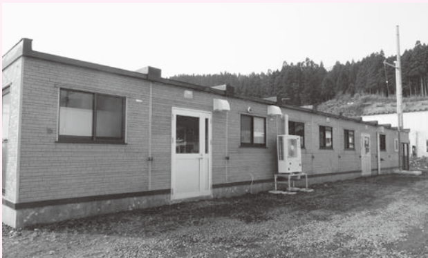
▲事務室、加工室を備える「管理棟」
