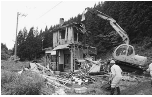
▲補助金を活用し、解体される空家
