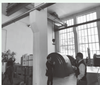
▲電力会社内部の様子
