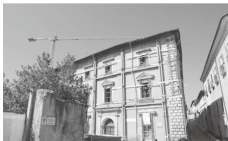
▲復旧作業中の住居
