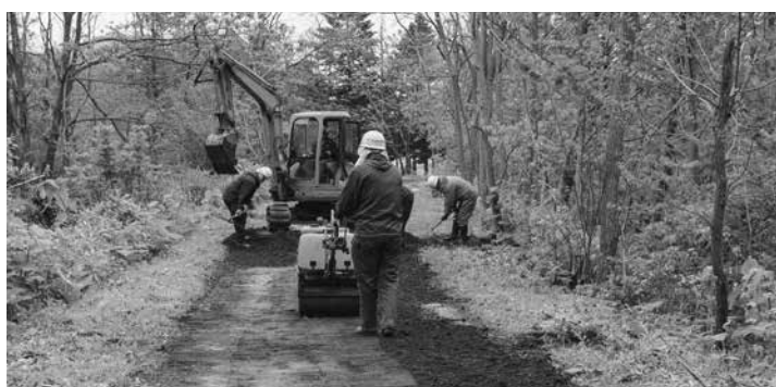
▲道路補修の様子
