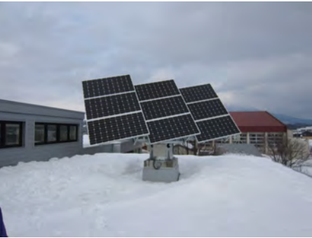
[写真] 太陽軌道追尾式太陽光発電装置の例
