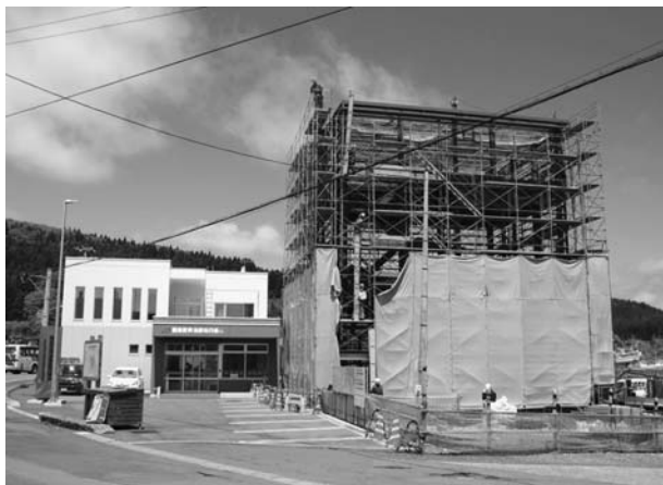
建設中の製氷貯氷施設
