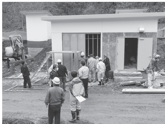
工事中の美山浄水場前処理施設
