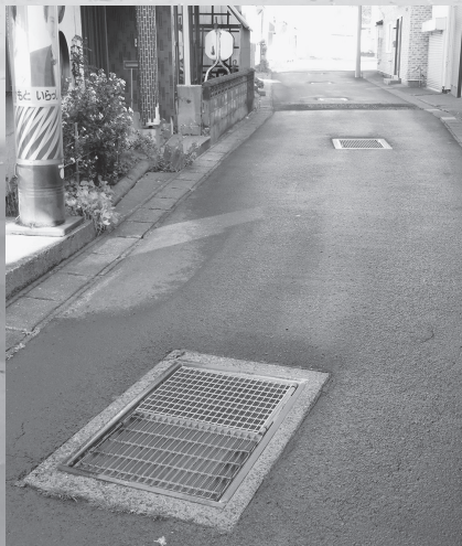
町内会要望があった吉岡地区 流雪溝蓋の取替 1,700万円
