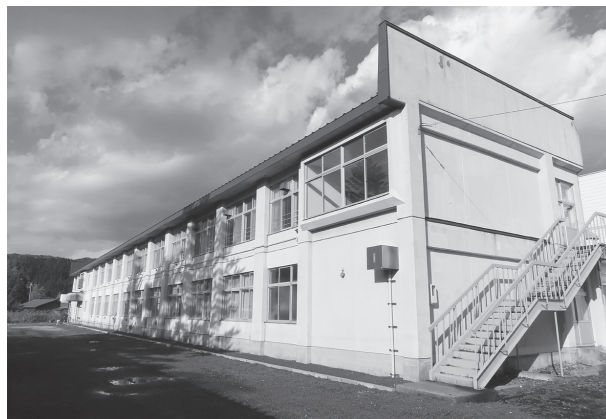
外壁補修工事が終わった南側校舎
