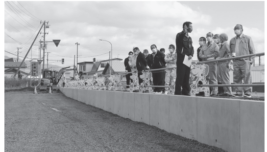
工事中の町道豊浜1号線
