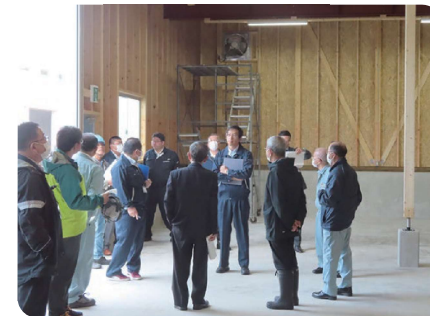
建設工事が進む有害鳥獣処理施設
