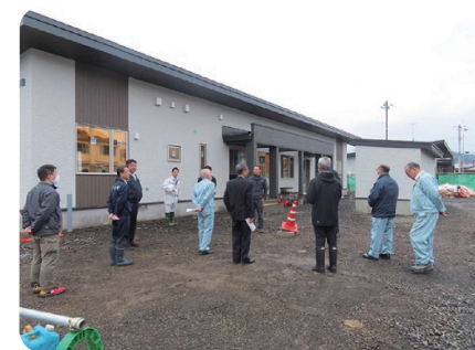
建設工事が進む町有住宅
