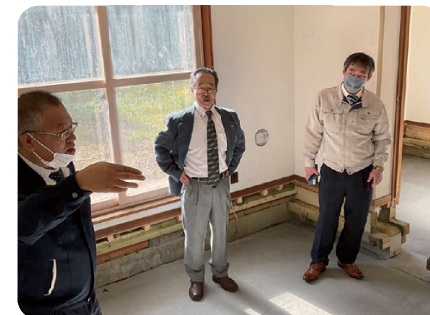
文化財の移設先として改修中の旧教員住宅
