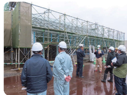
建設工事が進む種苗生産等施設
