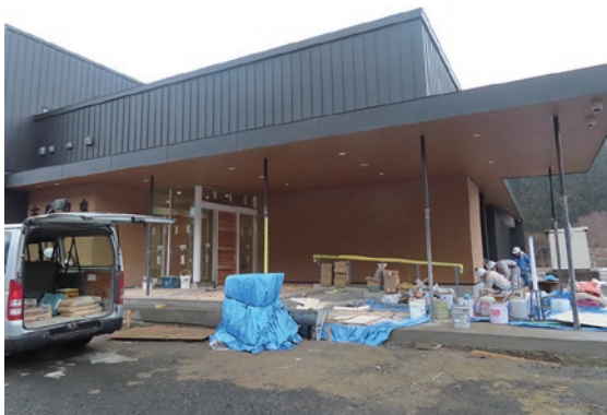
工事中の新しい吉岡温泉
