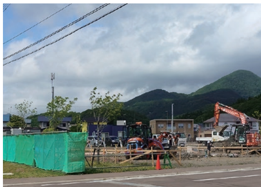
定住促進住宅建設現場
