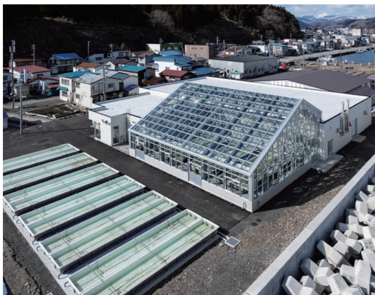
▲完成した「水産種苗生産センター」
