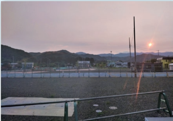
来年度に向けて増築工事が始まりました
