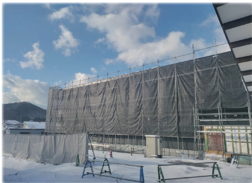
▲新棟も完成に向かっていきます
