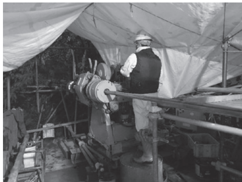
▲トンネル坑口部の地質調査
