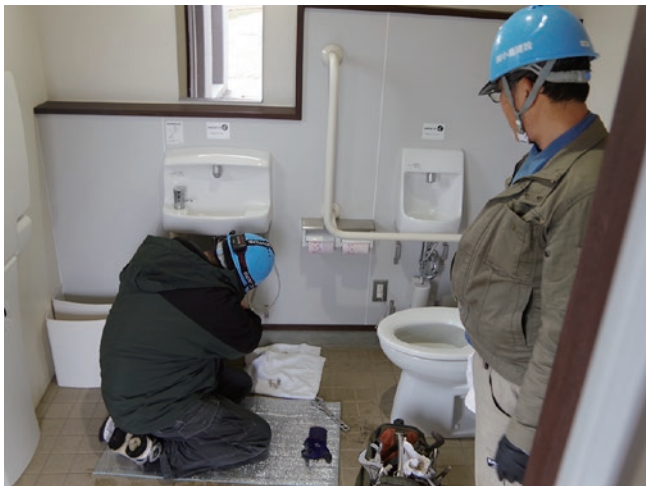
▲点検作業の様子
