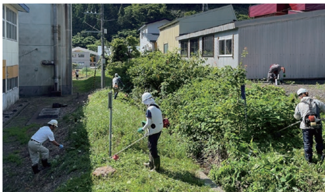
▲ 7月25日(金) 福島町建設協会による吉岡地区周辺の草刈り および樹木伐採の作業
