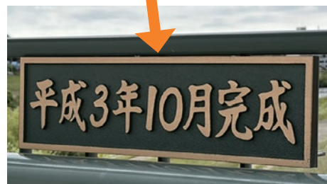
▲橋名板（金属製プレート）
