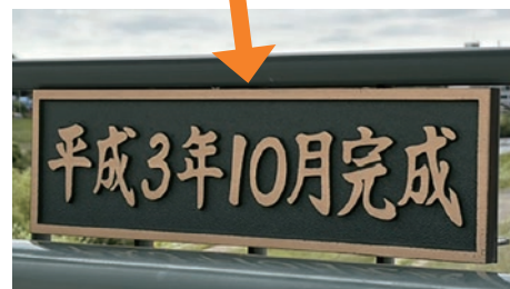
▲橋名板（金属製プレート）
